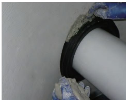
写真 1-29 モルタル充てん状況
