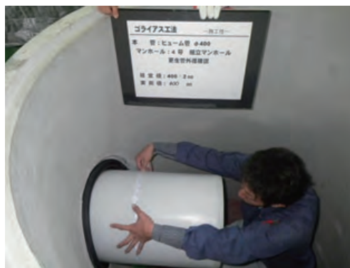
写真 4-18 更生管の外径確認
