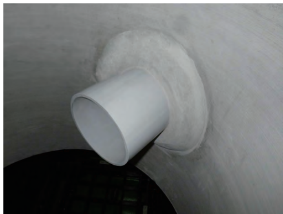
写真 1-31 管口仕上げ状況
