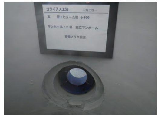
写真 4-22 特殊プラグ設置確認
