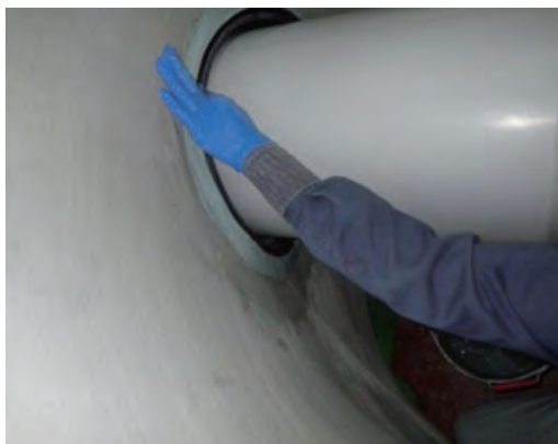
写真 4－30 エポキシ樹脂施工状況
