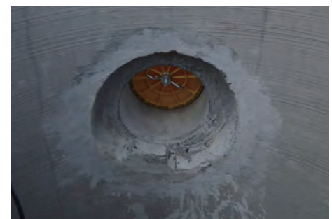
写真 1-21 既設管撤去状況
