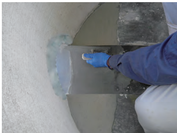
写真 1-32 インバート復旧状況
