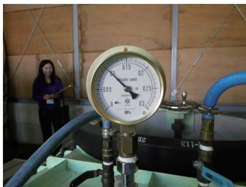
写真 4 - 35 水圧 0.1 MPa 確認
