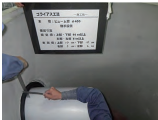
写真 4－28 耐震性継手設置確認
