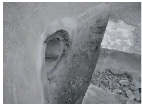
写真 1－25 既設管切断除去状況
