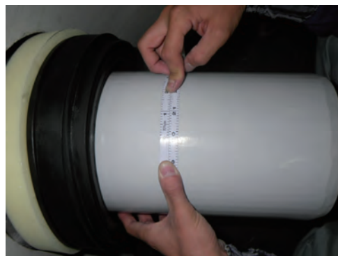
写真 1－27 更生管確認状況
