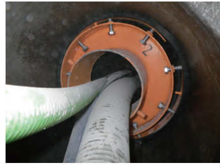
写真 1-19 特殊プラグ設置（下流側）
