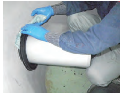
写真 4－26 エポキシ樹脂施工状況
