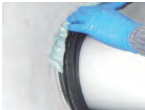
写真 1-30 エポキシ樹脂接着状況
