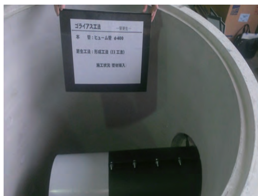
写真 4－15 管更生施工状況
