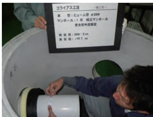
写真 4-17 更生管の外径確認
