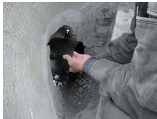
写真 1－26 管更生用ガイド管設置状況
