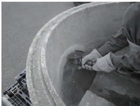
写真 1－24 エアー工具による切断除去状況
