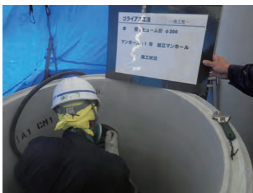
写真4-4 マンホール壁の切削状況
