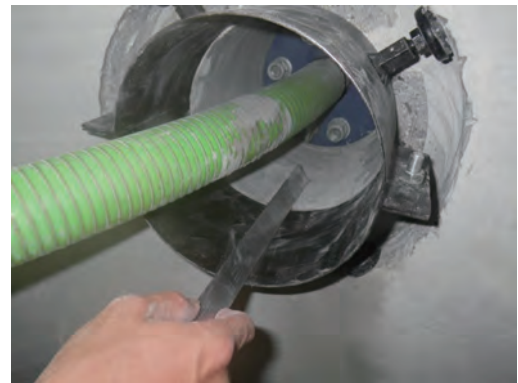
写真 4-11 管更生用ガイド管設置確認 (管底の一致確認)
