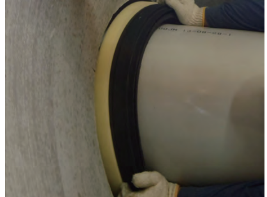
写真 1-28 耐震性継手の挿入状況
