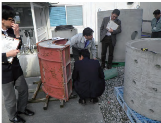
写真 4-2 資機材搬入の試験状況
