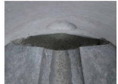
写真 1-20 インバート撤去状況
