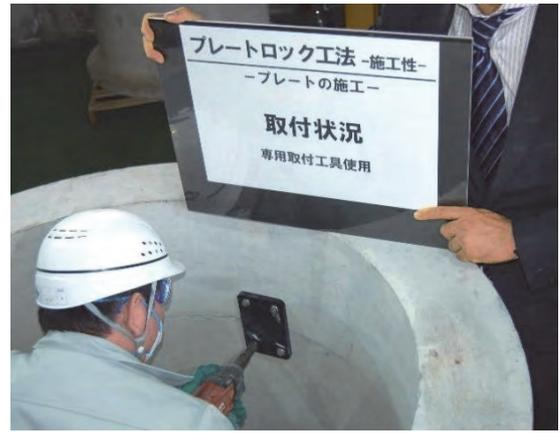
写真 4 - 11 プレートの取り付け状況
