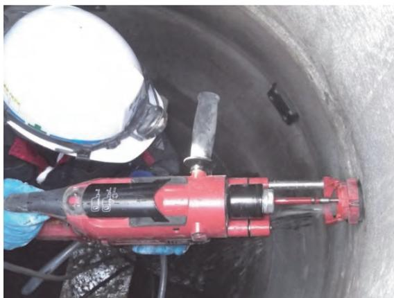
写真1-10 アンカー用下穴削孔状況
