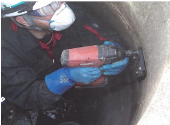
写真1-11 プレートの取り付け状況
