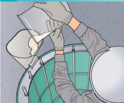
マンホールと樹脂セグメントの隙間にセメントミルクを充填します。
