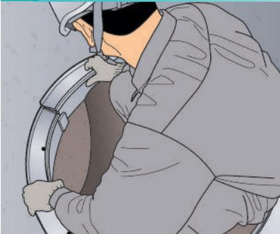
分割構造の管取セグメントを、インバート形状に合わせ設置します。
