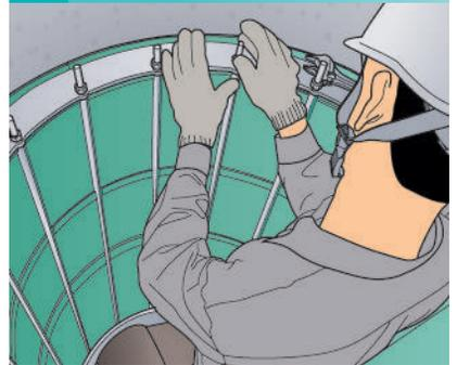
テンションロッドで、管取セグメントと上部プレートを緊結します。
